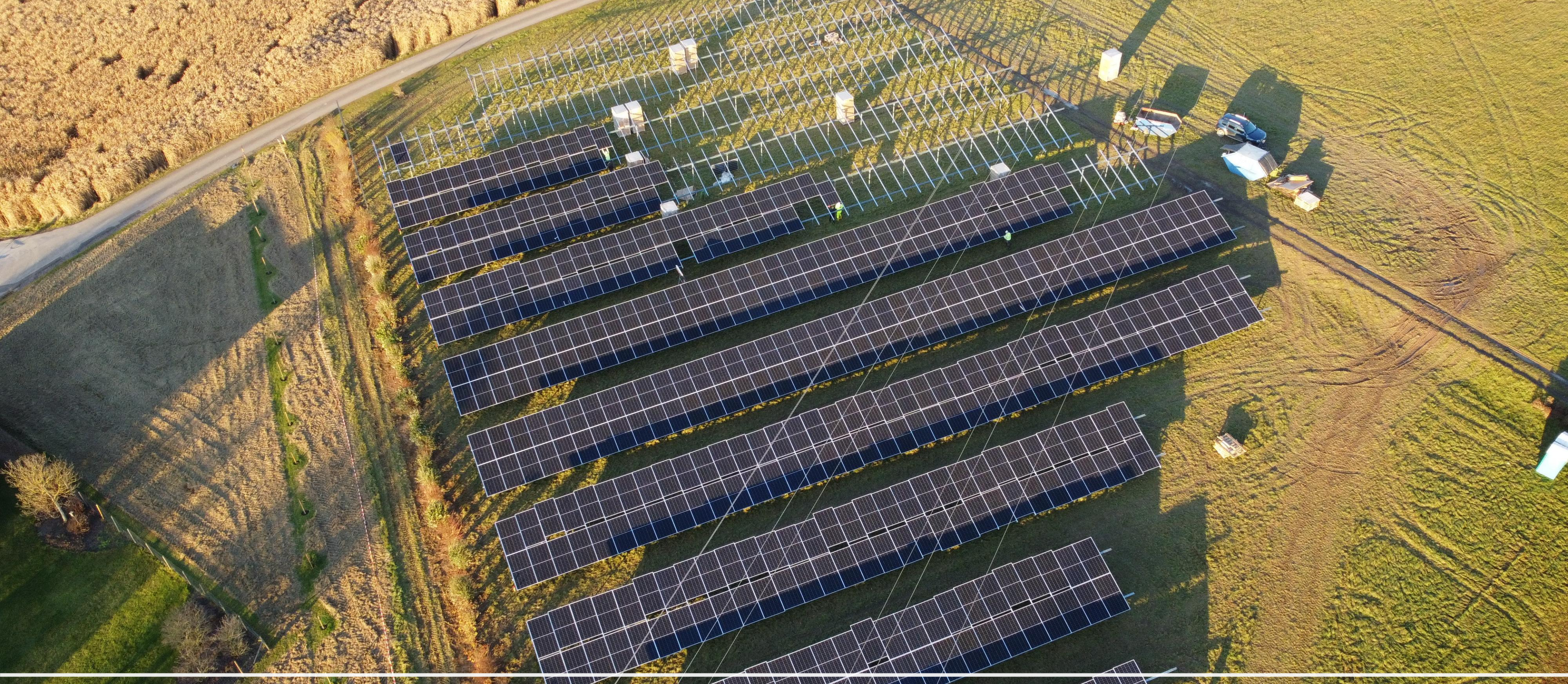
AGRI-PV-ANLAGE Engerwitzdorf, 600 kWp
